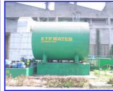
TTP Water storage Tank
